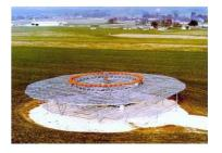
Радиомаяки VOR состоят из двух передатчиков. Первый передает постоянный сигнал во все стороны, в то время как второй передатчик представляет собой узконаправленный вращающийся луч, изменяющийся по фазе в зависимости от угла поворота. Принимающая аппаратура сравнивает оба сигнала и определяет «угол луча», на котором в данный момент находится самолет. Такой угол называется радиалом.
